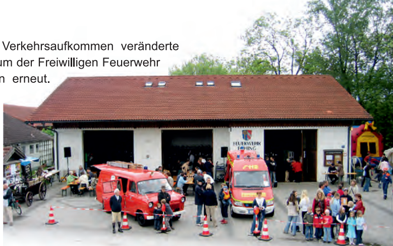
Feuerwehrgerätehaus am Tag der offenen Tür 2006
